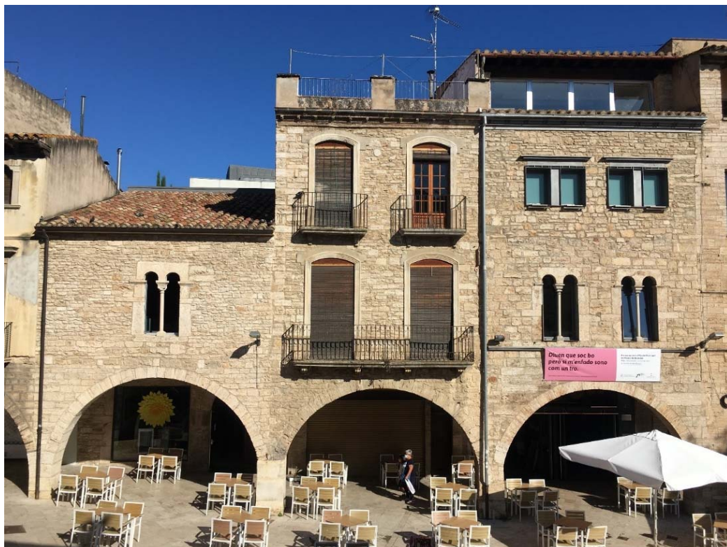
Façana principal, estat actual
